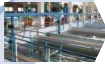
МУП «УПРАВЛЕНИЕ «ВОДОКАНАЛ»
